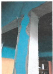
Foto 5: REPARACIÓN DE REPELLO Y CERNIDO DE PAREDES Reparación de repello y cernido en muro de mampostería con aplicación de acabado uniforme. Cocina
