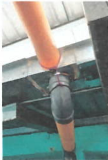
Foto 3: CANALES Y BAJADAS DE AGUA PLUVIAL sustrucción de bajantes para evacuación de aguas pluviales anclada por medio de abrazaderas y tornillos
