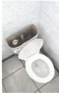
Foto 1: SERVICIOS SANITARIOS Y SUS ACCESORIOS Sustrucción de sanitarios lavables, accesorios y conexiones.
